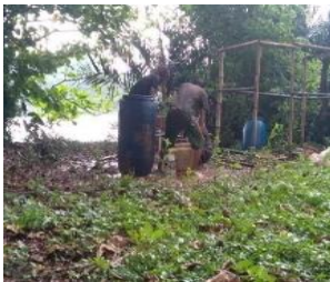
Proses Pembuatan Sumur Bor
