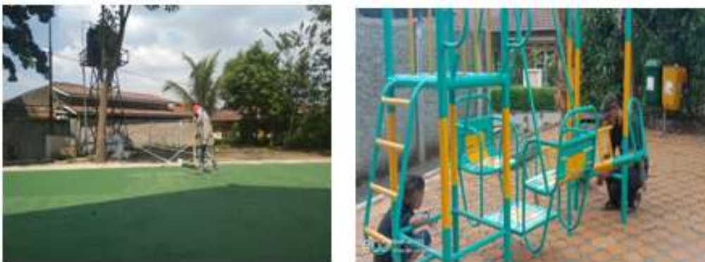
Gambar 6. Pembersihan lahan dan pemasangan permainan anak
