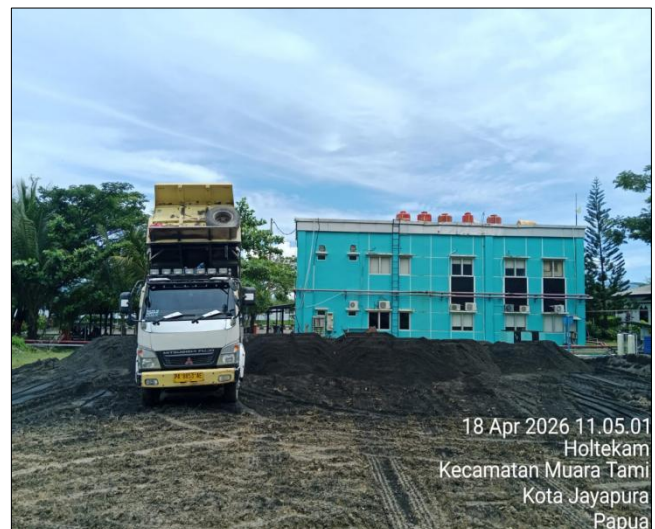
Gambar 2. Proses Unloading FABA untuk Subgrade Lahan Internal PLTU Holtekamp
