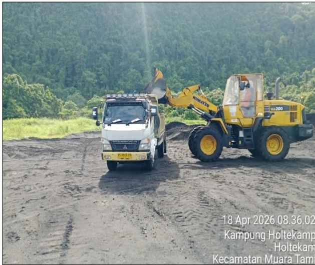
Gambar 2. Proses Unloading FABA untuk Subgrade Lahan Internal PLTU Holtekamp
